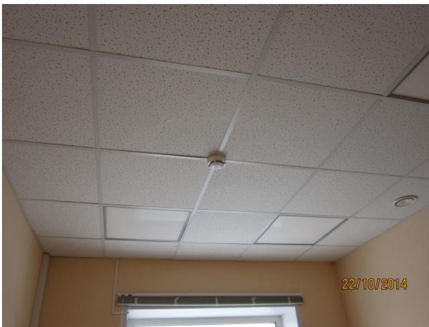
Рисунок 19. Неправильная ориентация извещателя в помещении
