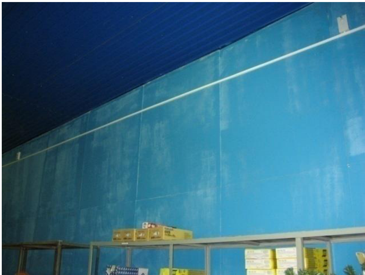
Рисунок 37. Расстояние до перекрытия менее 0,8 м
