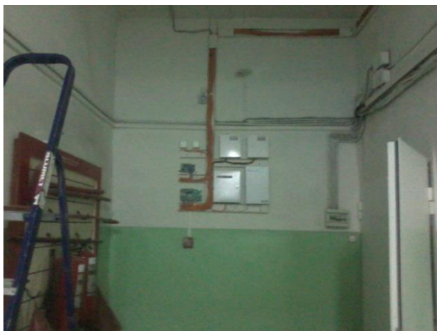
Рисунок 22. Неправильное размещение приборов управления
