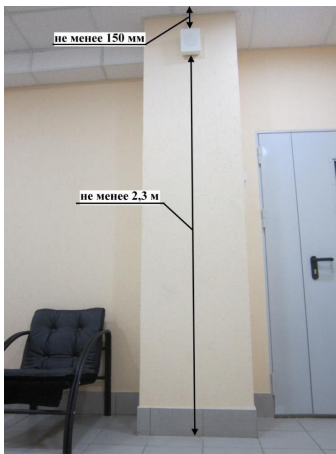
Рисунок 8. СПЗ.13130.2009 к п. 4.4 Настенные звуковые и речевые оповещатели должны располагаться таким образом, чтобы их верхняя часть была на расстоянии не менее 2,3 м от уровня пола, но расстояние от потолка до верхней части оповещателя должно быть не менее 150 мм.
