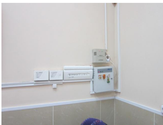
Рисунок 14. Неправильное размещение приемно-контрольных приборов
