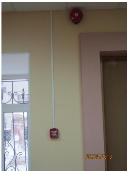
Рисунок 17. Неправильное размещение оповещателя
