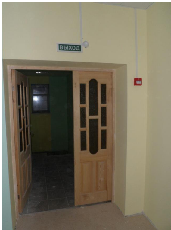
Рисунок 13. Неправильное размещение ручного пожарного извещателя
