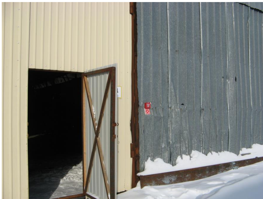
Рисунок 29. Применен ИПР, не предназначенный для установки снаружи помещения.
