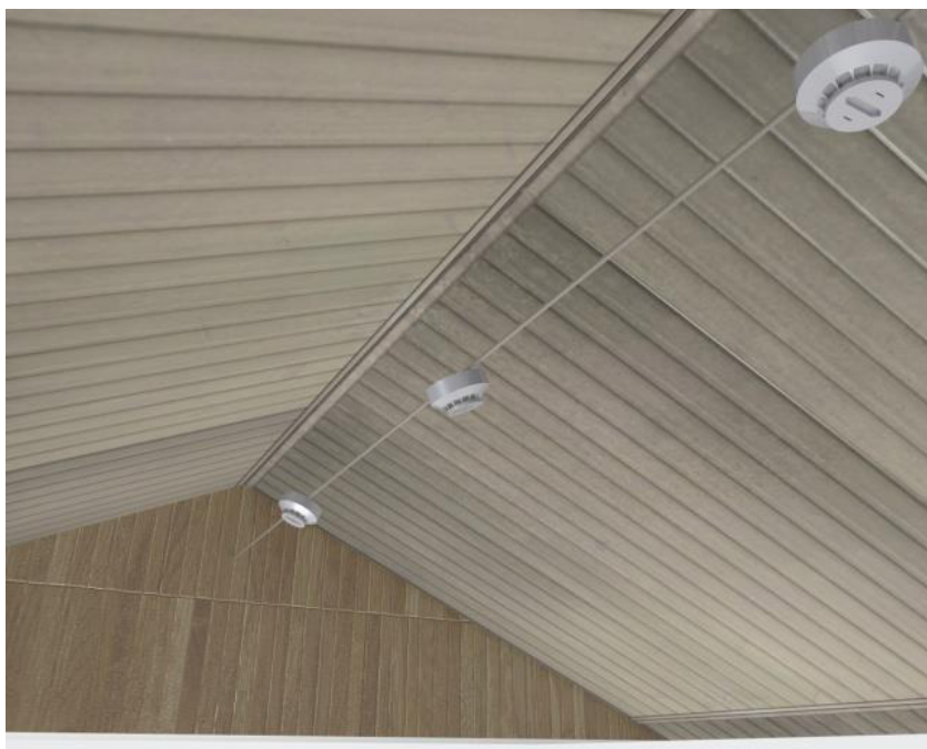
Рисунок 23. Неправильное размещение извещателей на тросе
