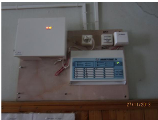
Рисунок 15. Неправильное размещение приборов на негорючем основании
