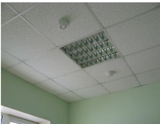
Рисунок 16. Неправильное размещение извещателей на подвесном потолке (ближе 50 см к осветительному прибору)
