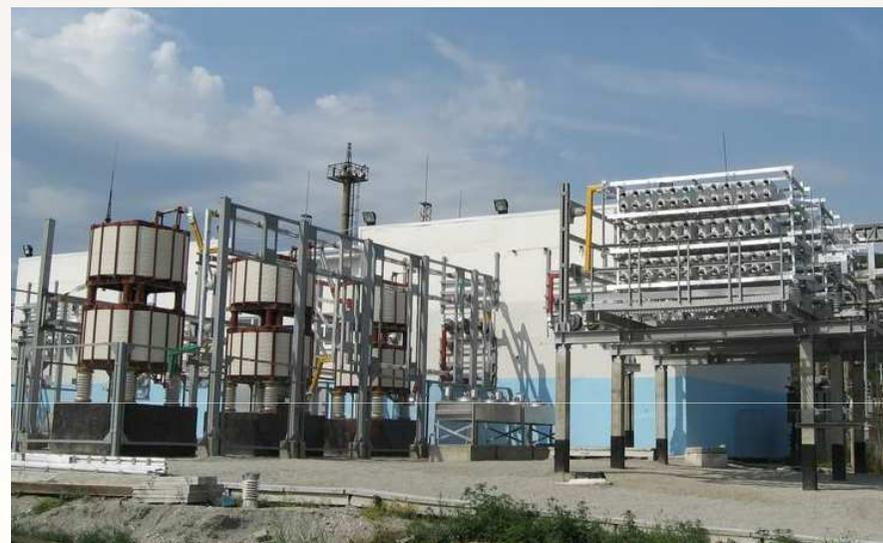
В России освоено производство статических тиристорных компенсаторов (СТК) мощностью 50, 100 и 160 Мвар на класс напряжения 6-35 кВ на полностью отечественной элементной базе. Разработка ОАО «НТЦ ФСК ЕЭС».
