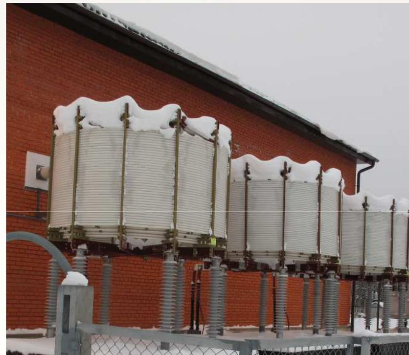
СТАТКОМЫ с функцией регулирования напряжения и компенсации реактивной мощности.
