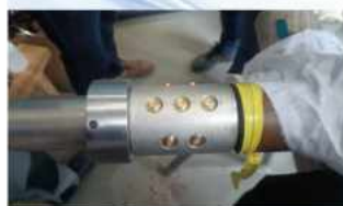
Установка оконцевателя
