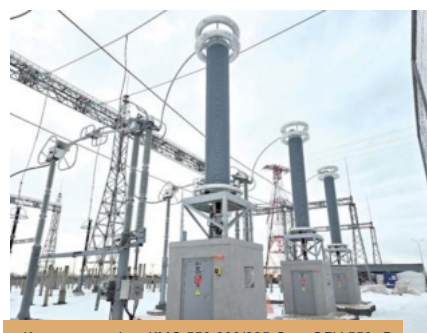
Концевые муфты КМС 550-800/225-О на ОРУ 550 кВ
